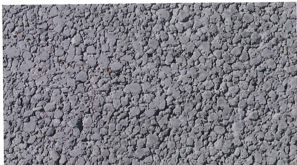
ダイレクト仕上
